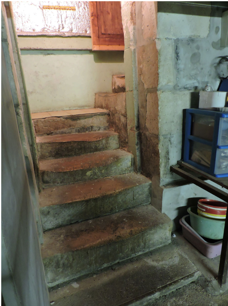
Escalier au sous-sol de l'auberge.
