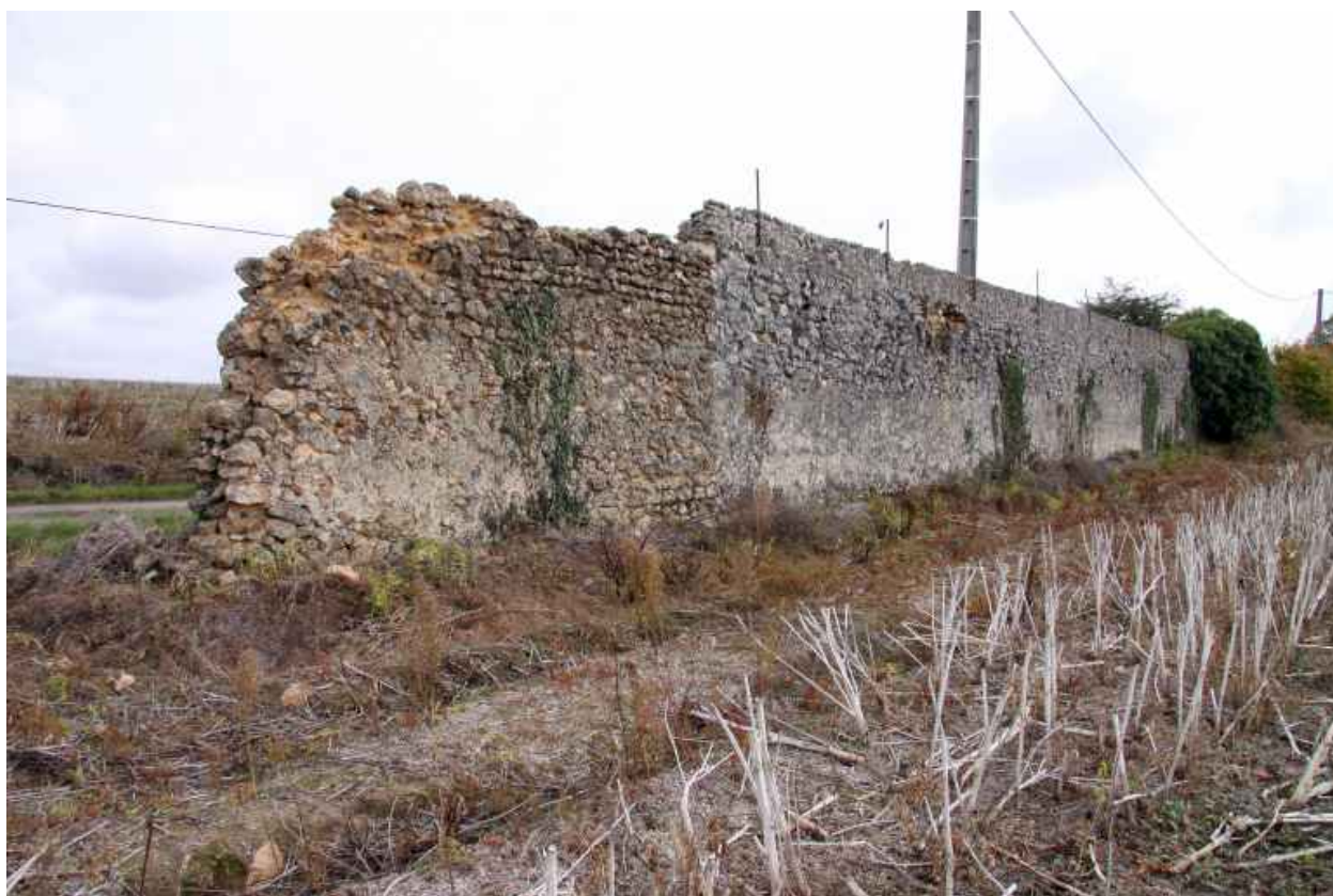
Le mur de clôture : façade interne (ancien potager ?).
