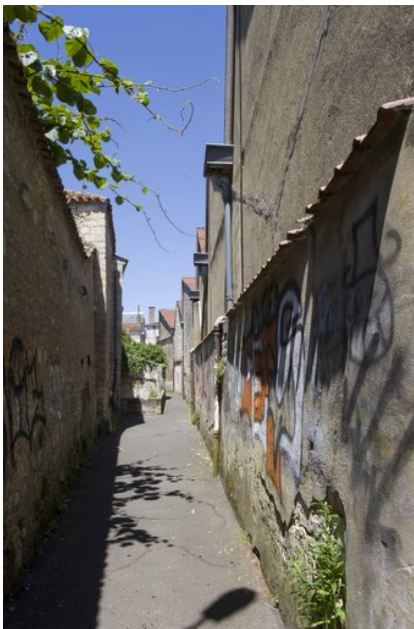
Ruelle de l'Ecours des halles (vue prise du sud).
