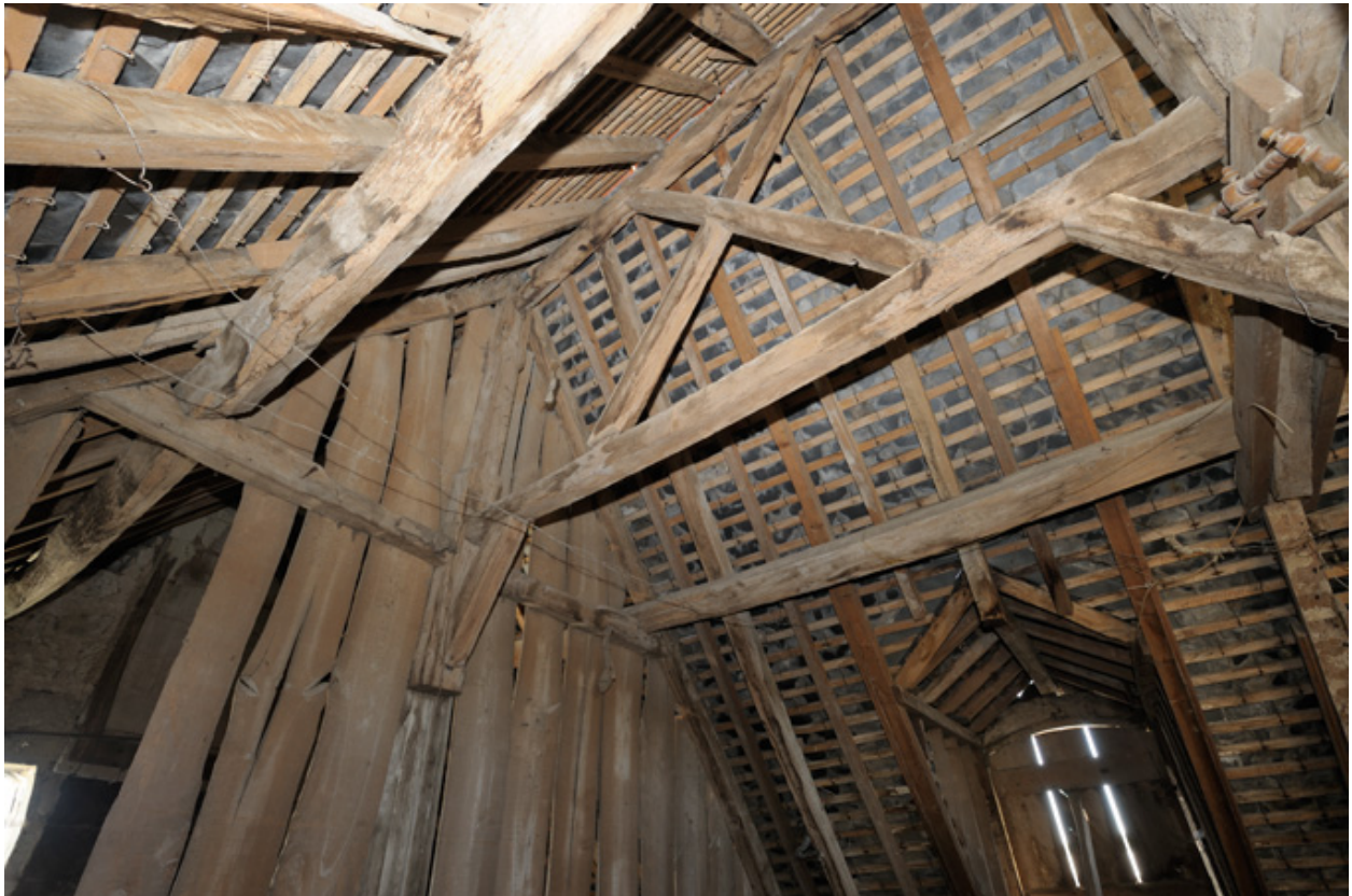
Comble. Charpente, avec panne sur entrait retroussé.
