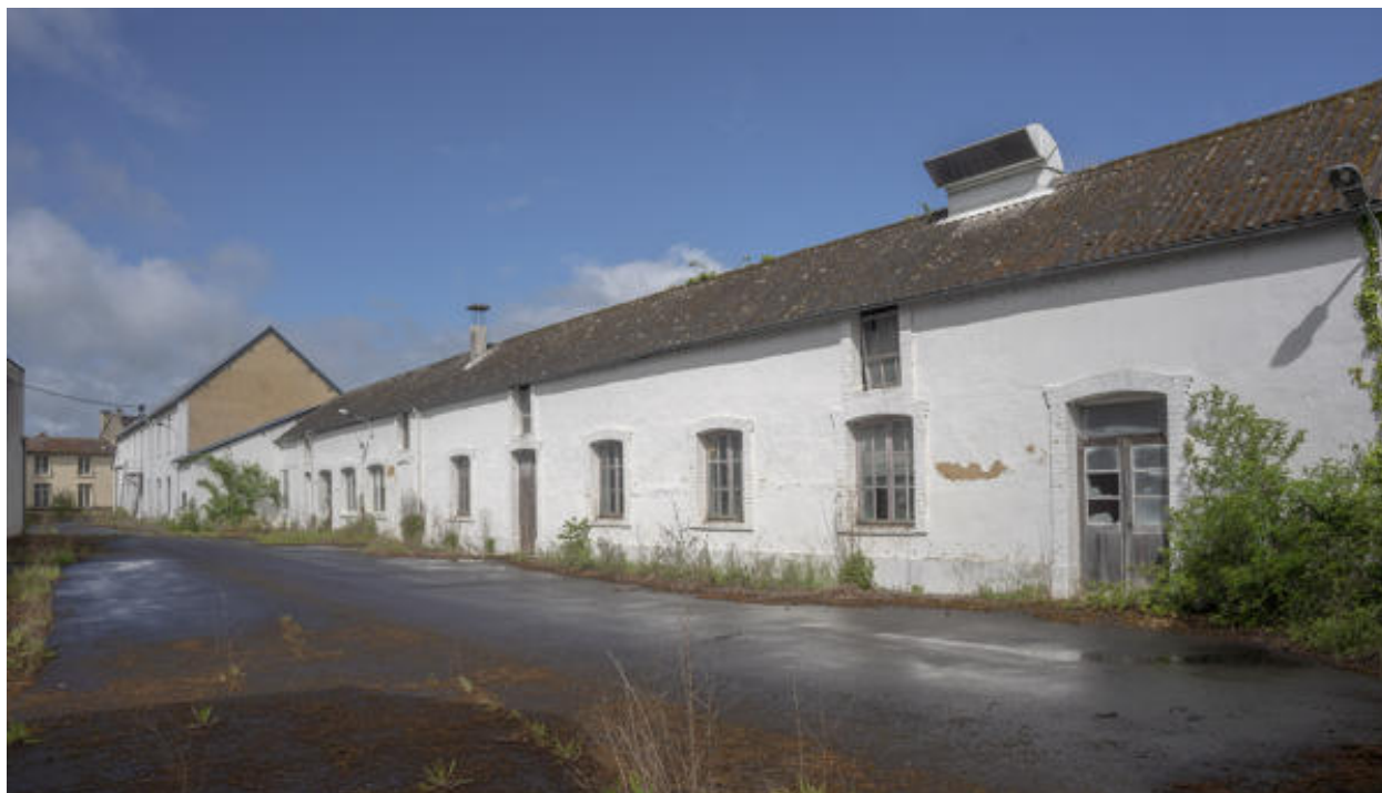
Elévation sud de la partie droite du bâtiment E de l'usine textile.
