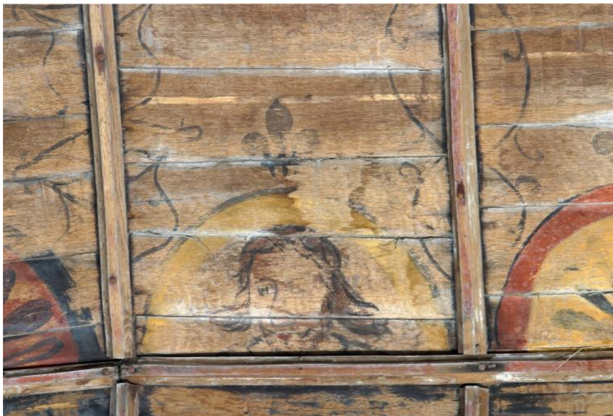
Nef, voûte, côté sud, première travée, registre supérieur : tête d'homme.
