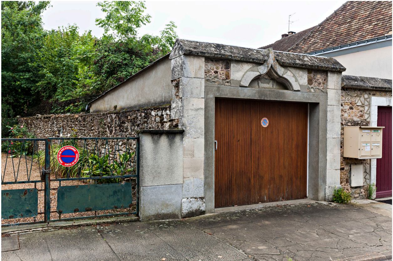
Ancienne allée couverte menant du parc à la rue de Luynes.
