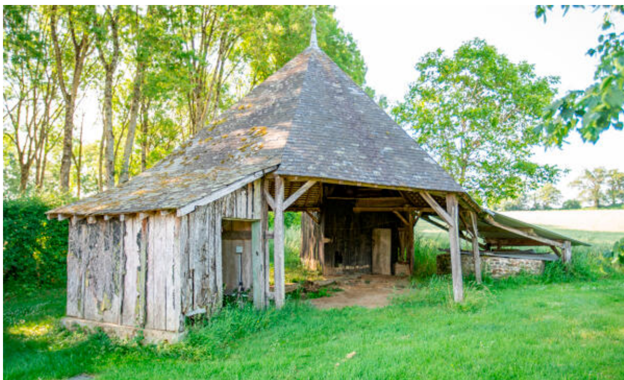
Le manège du puits artésien.
