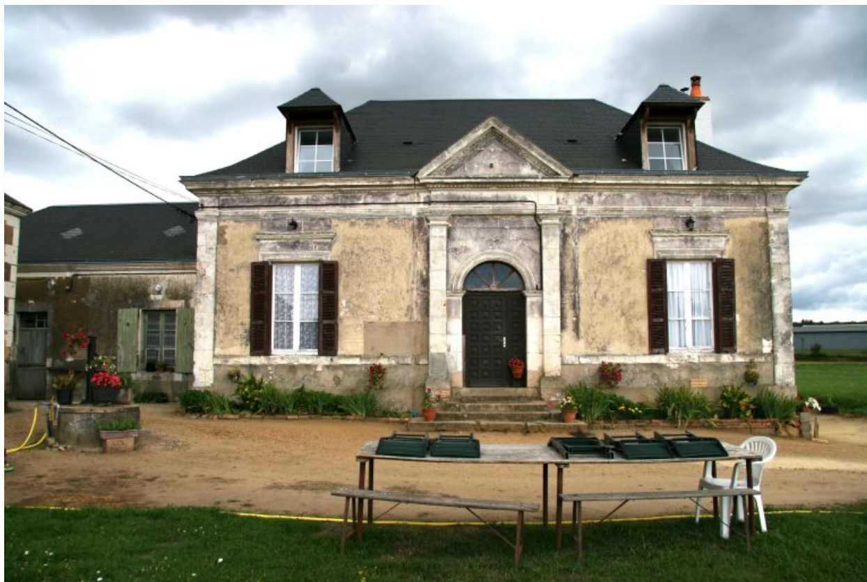
La maison : façade antérieure sur cour.
