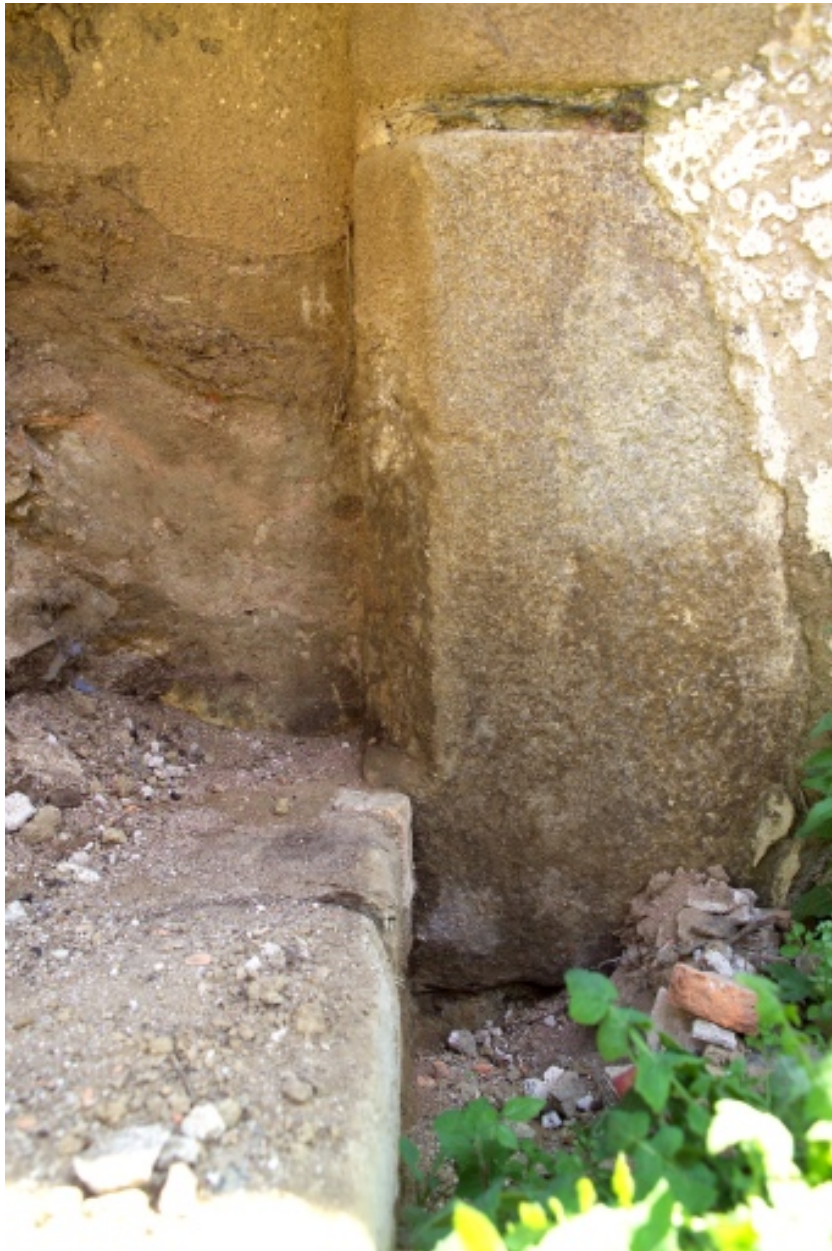
Cheminée de la partie est, détail du jambage et de la sole en granite.
