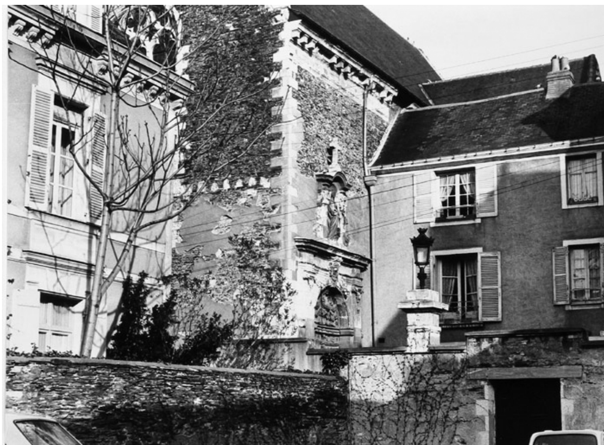
Angle sud-ouest de l'église avec le portail d'entrée. A gauche, bâtiment conventuel (actuel hôtel du Mail) ; à droite, ancienne maison des Tourières.
