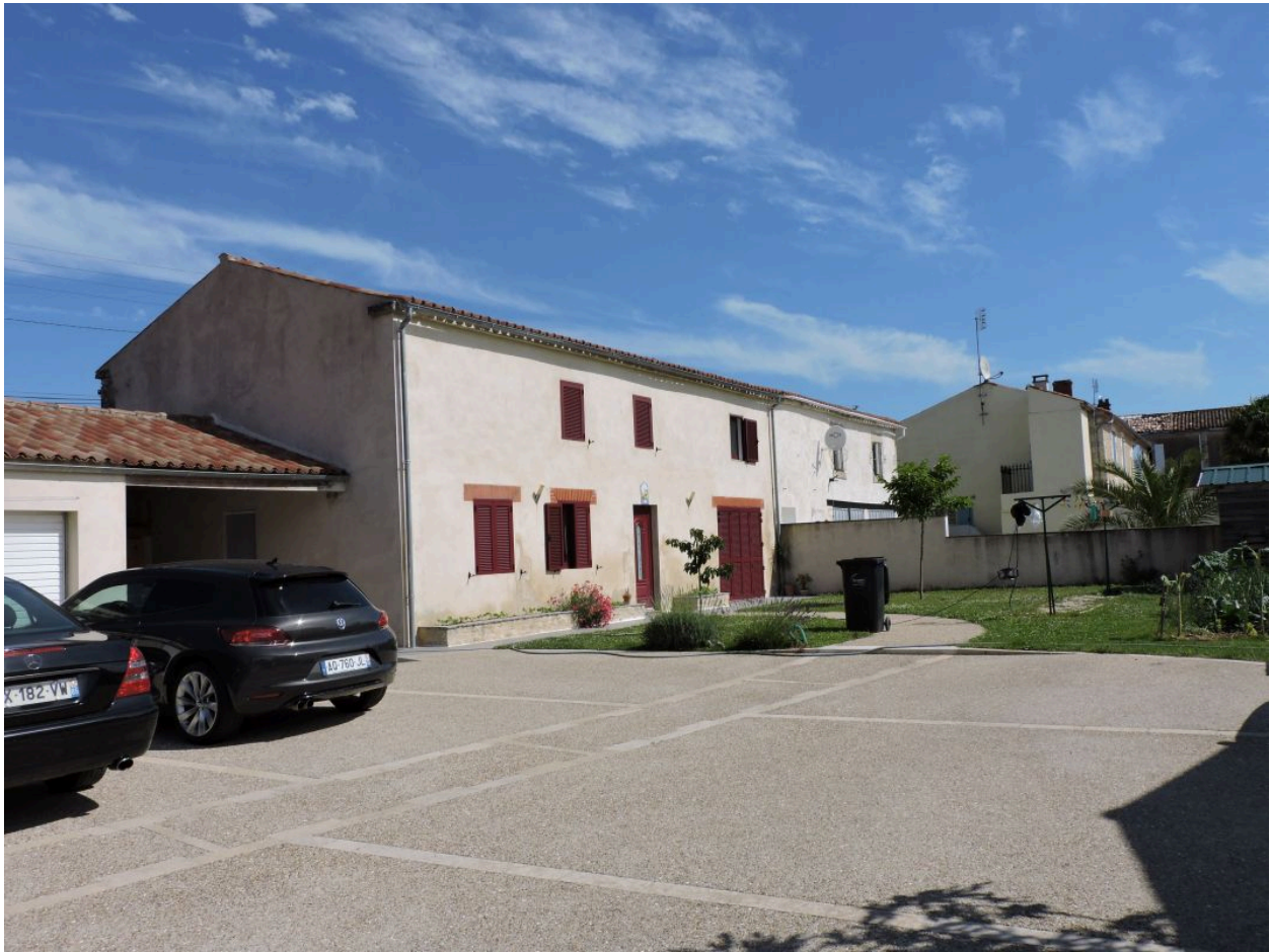
L'ancienne scierie, au sud-ouest de la maison, vue depuis le sud.
