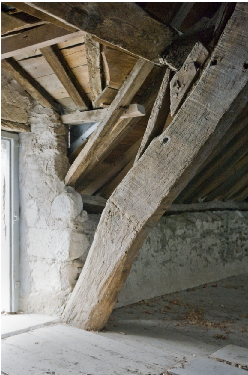
15 rue Jeanne-de-Navarre. Comble. Détail du surcroît.
