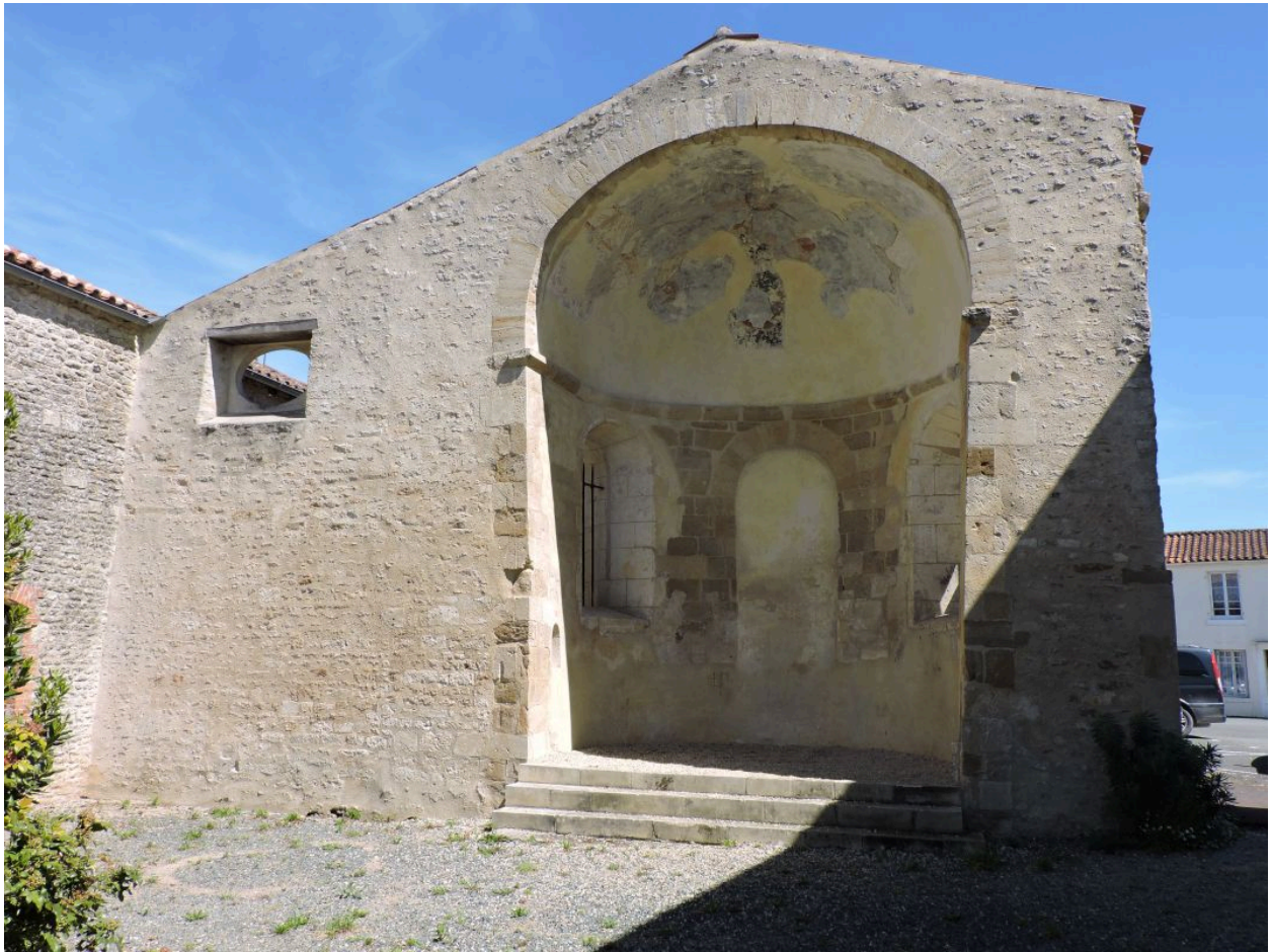
L'abside, choeur de l'ancienne église, vue depuis l'ouest.
