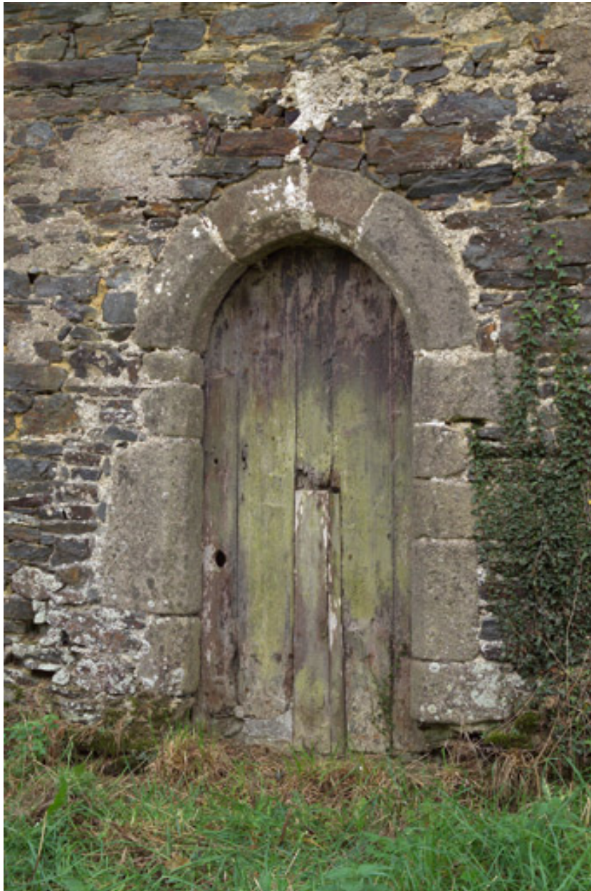
Porte sur l'élévation postérieure, partie est.
