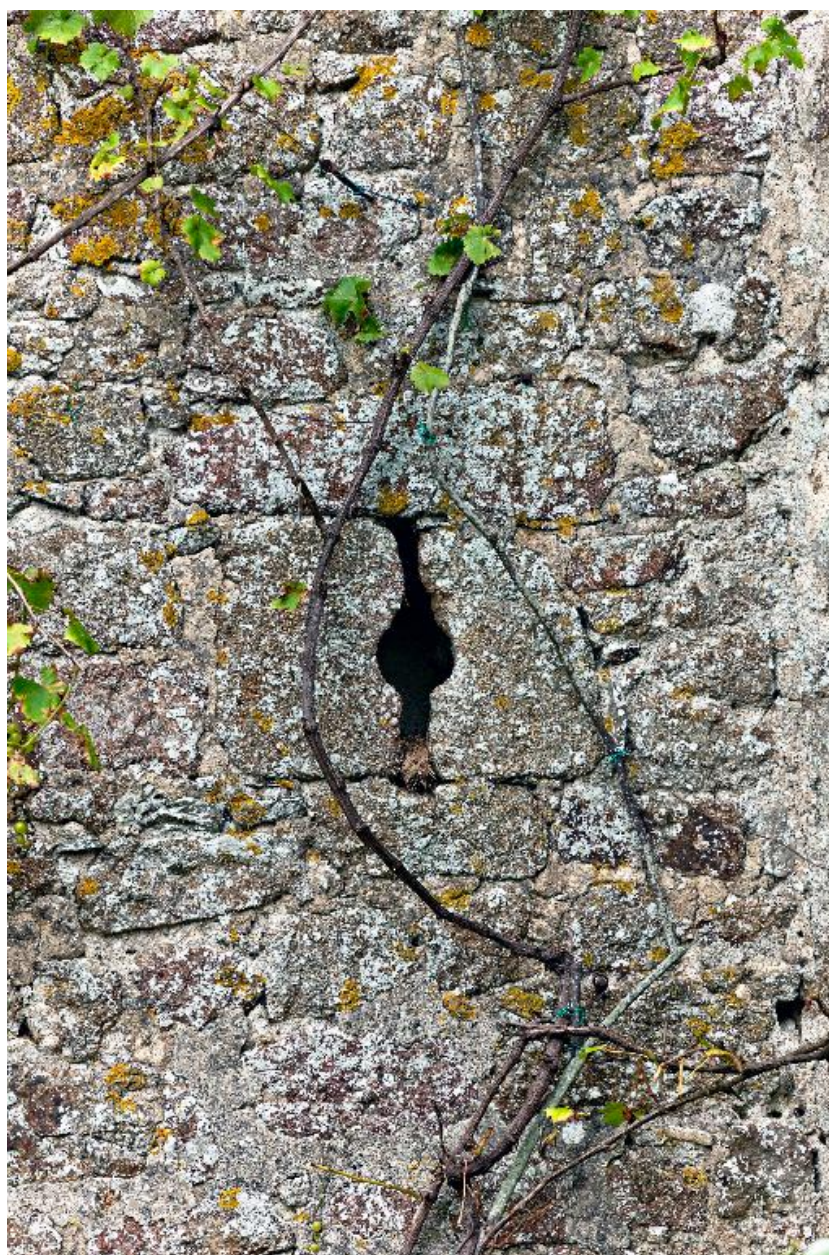
Vue de détail de la tour nord : canonnière percée dans le mur sud, au rez-de-chaussée.
