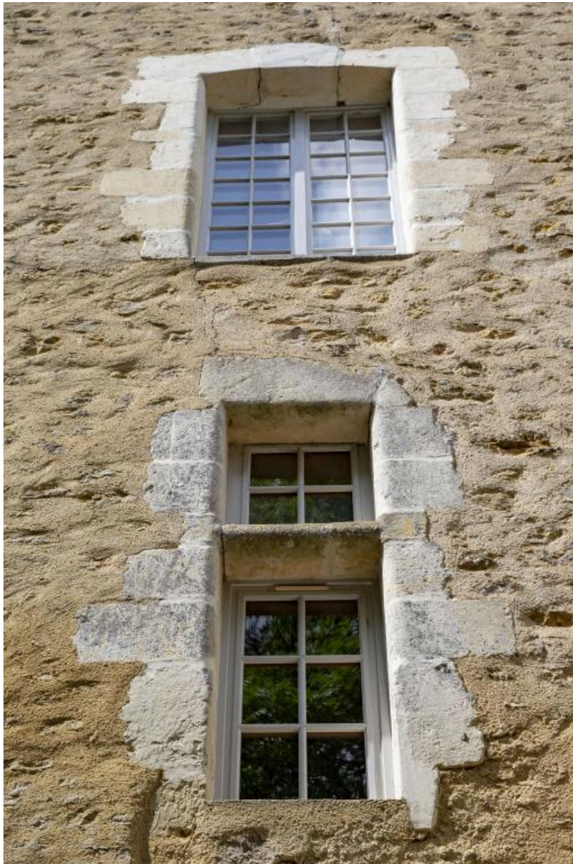
Les fenêtres du pignon est.
