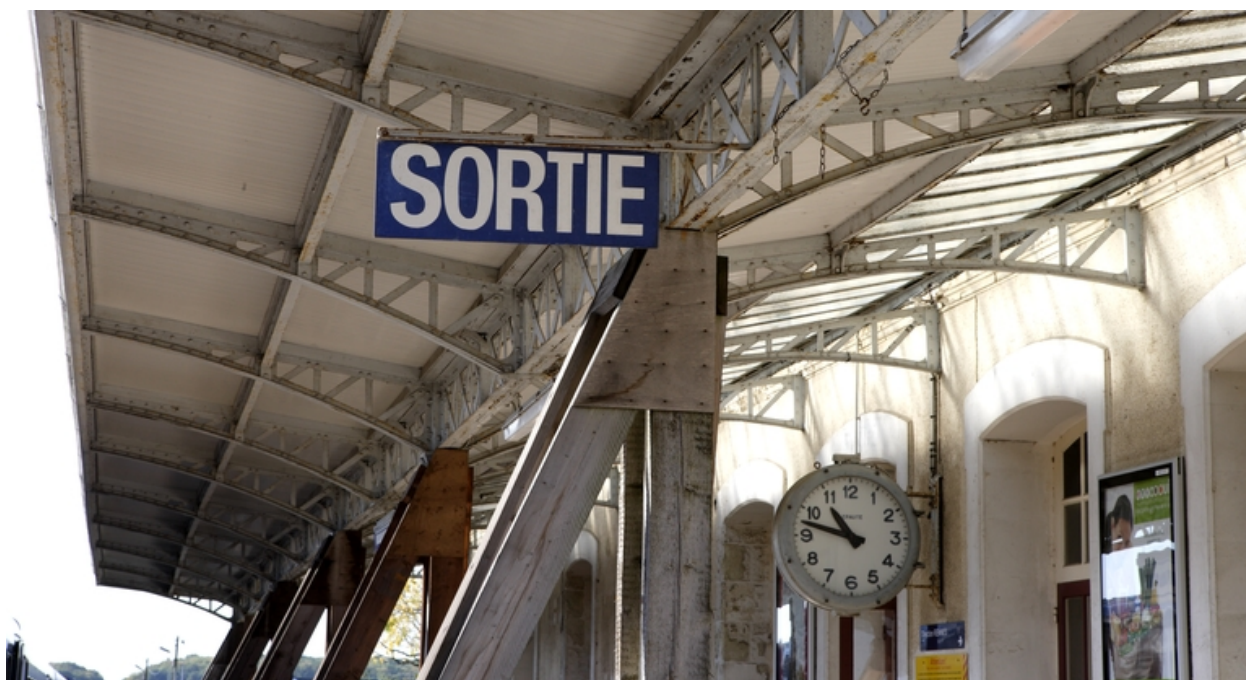
Marquise protégeant le quai principal.
