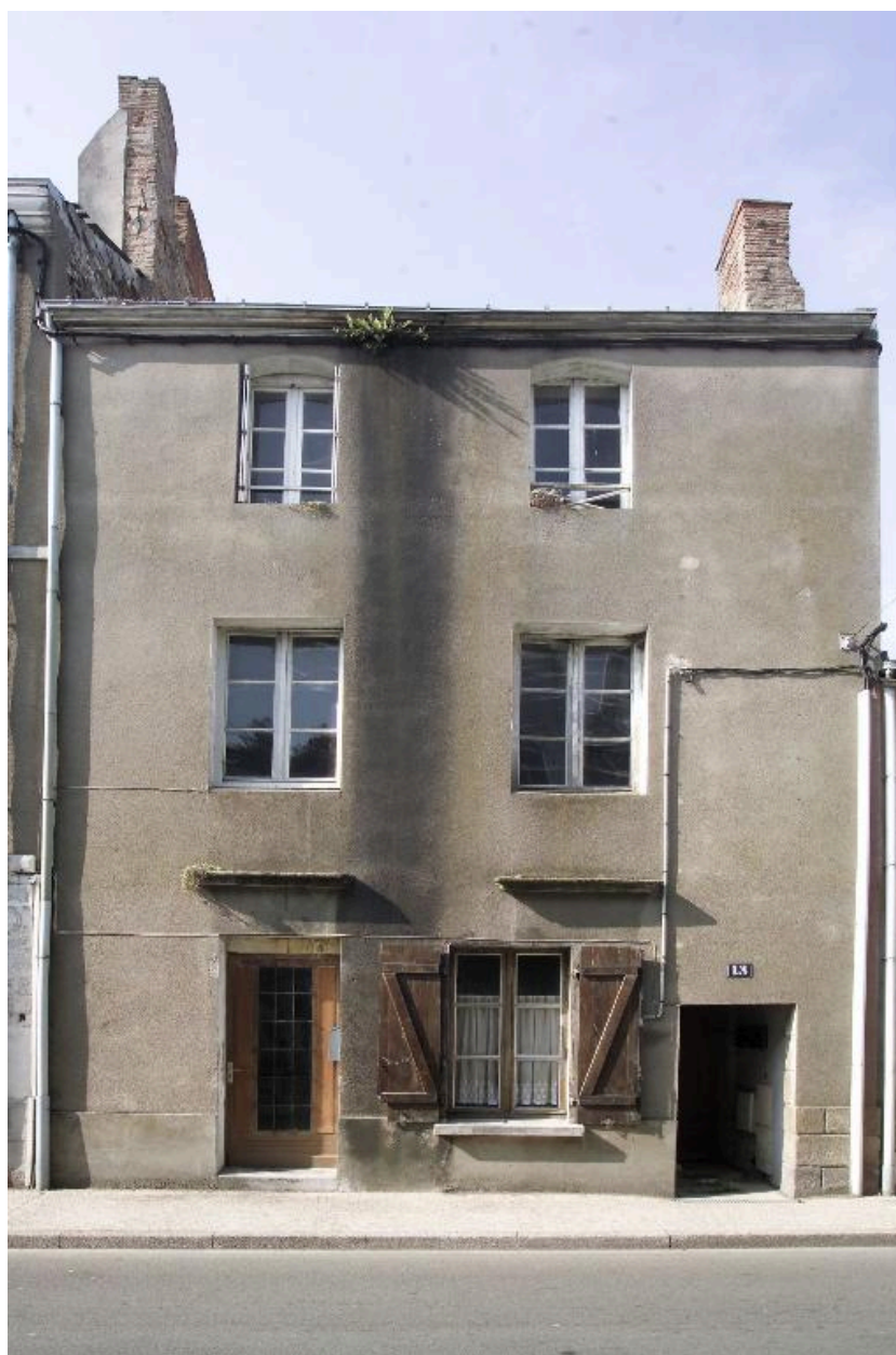
13, rue du Général-De-Gaulle.
