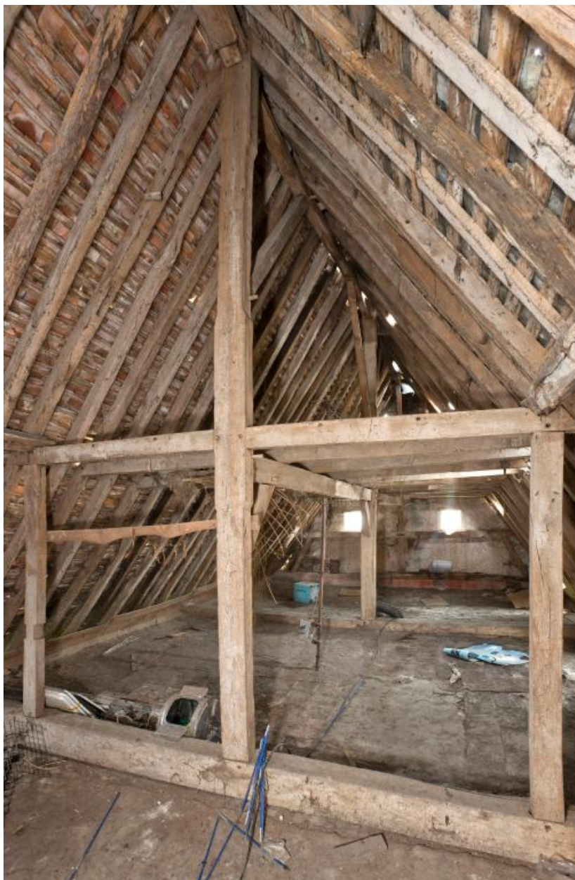
Comble : charpente à pannes.
