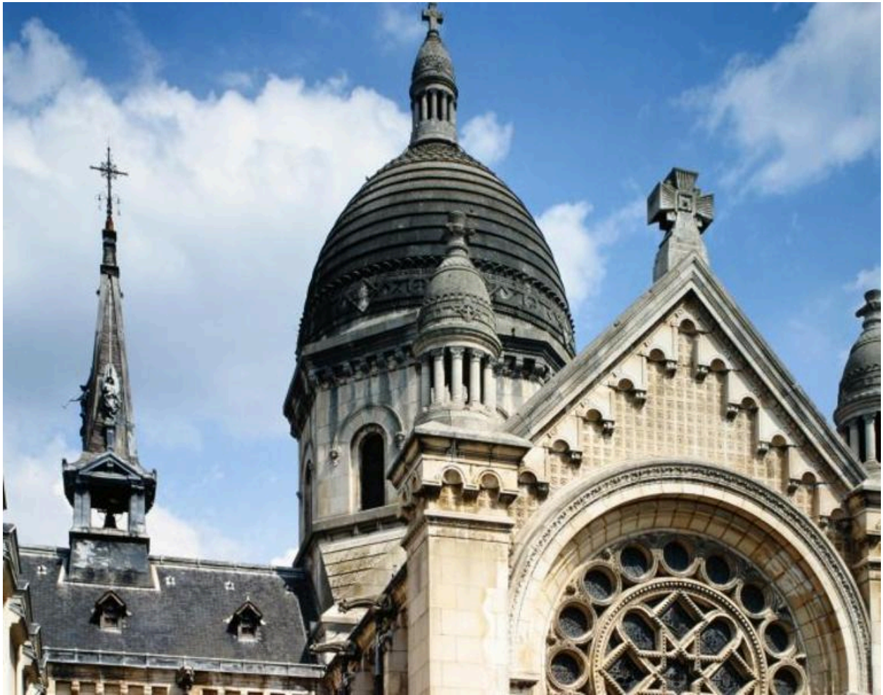
Dôme et campanile : vue d'ensemble.
