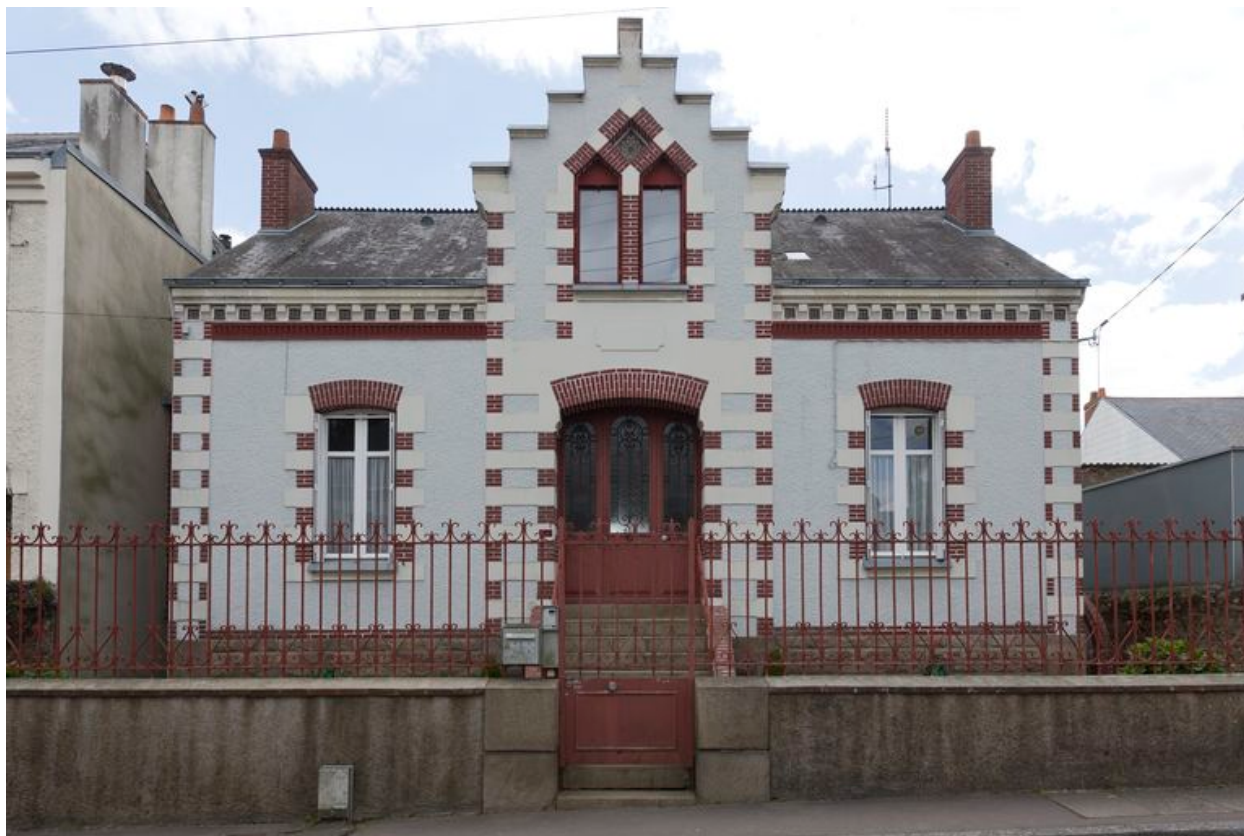
Maison, 19 rue de l'Abbaye.
