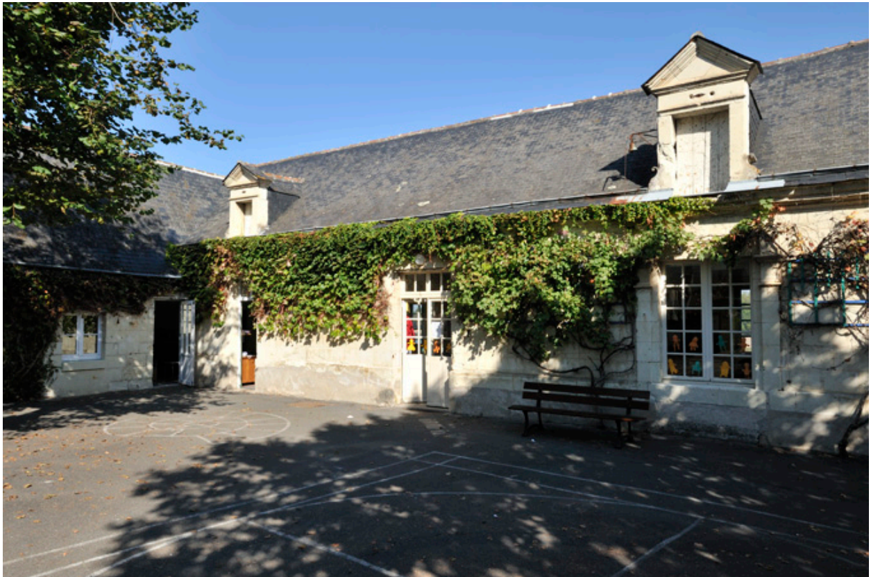
Corps ouest, bâtiment principal, depuis la cour.
