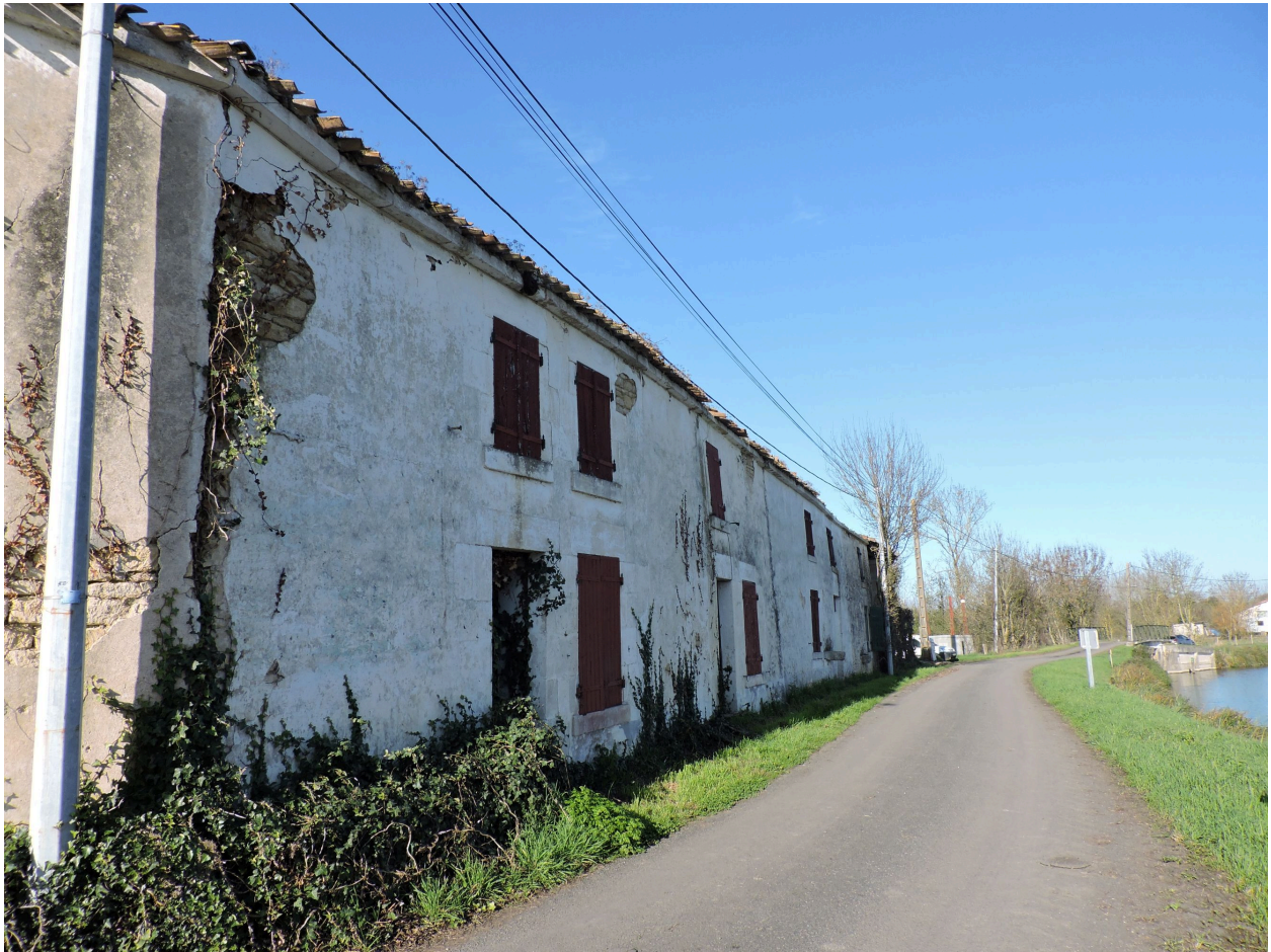
La façade du logis vue depuis le sud.
