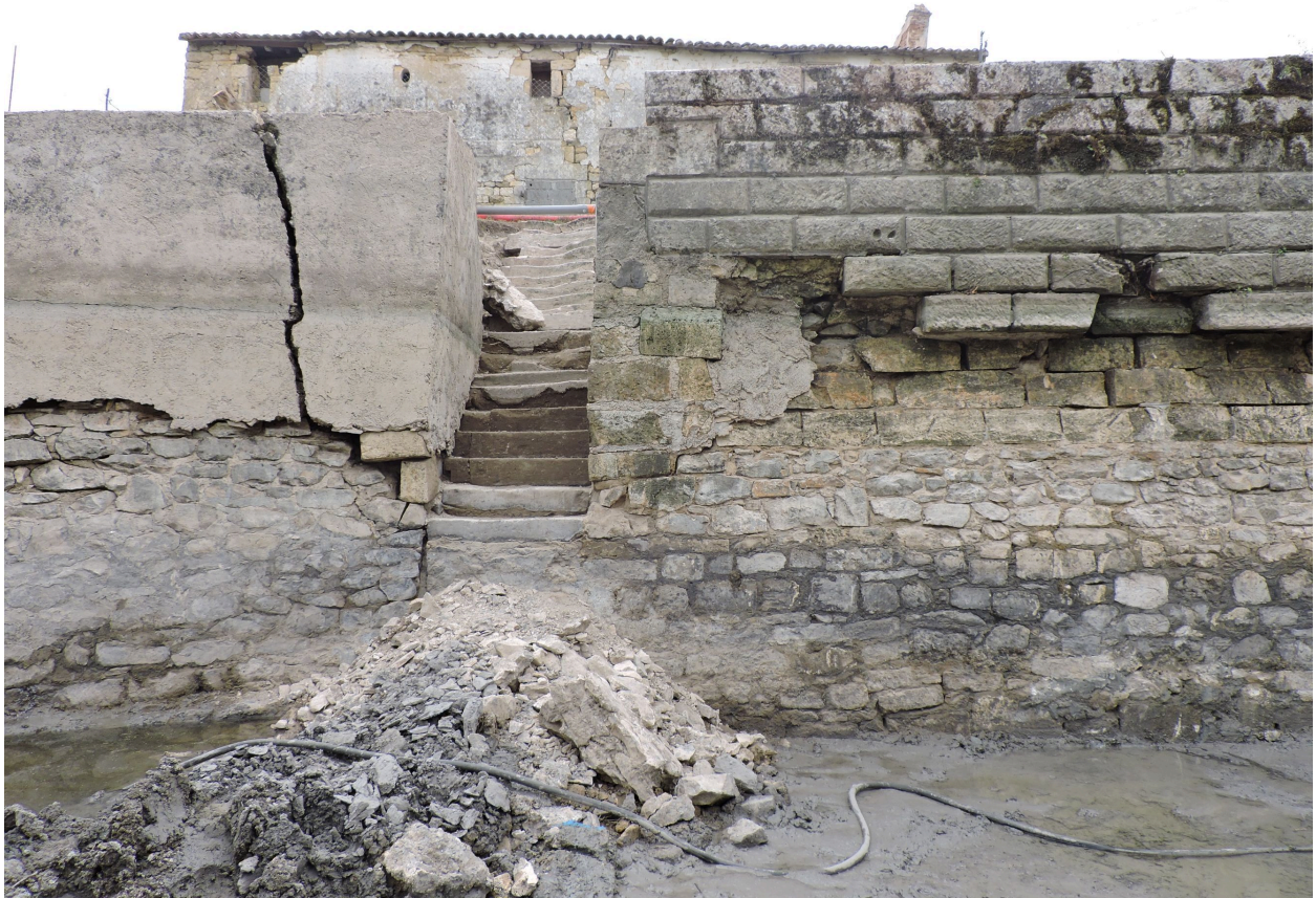
Août 2020 : quai empierré et escalier sur la rive gauche du canal de Vix, en amont de l'aqueduc, avant restauration.
