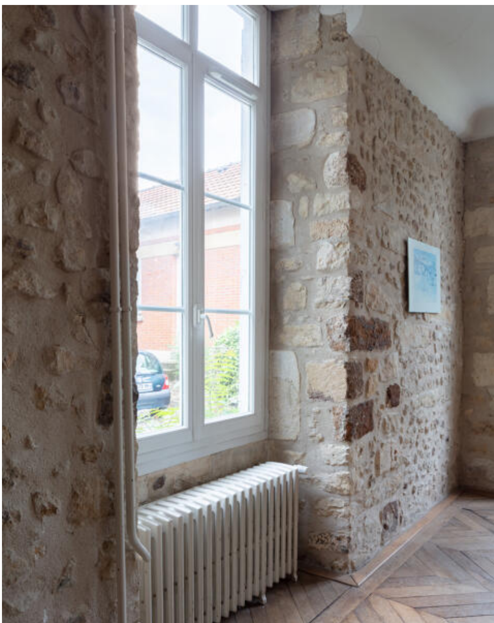
Vue des pierres en calcaire et grès roussard formant le chainage d'une fenêtre.
