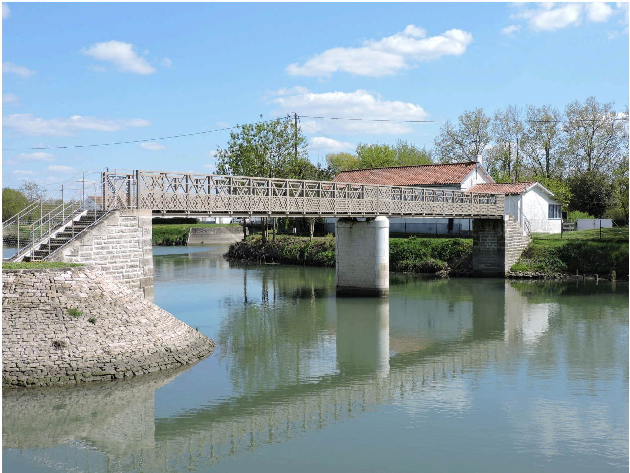
La passerelle vue depuis l'aval, au nord-ouest.
