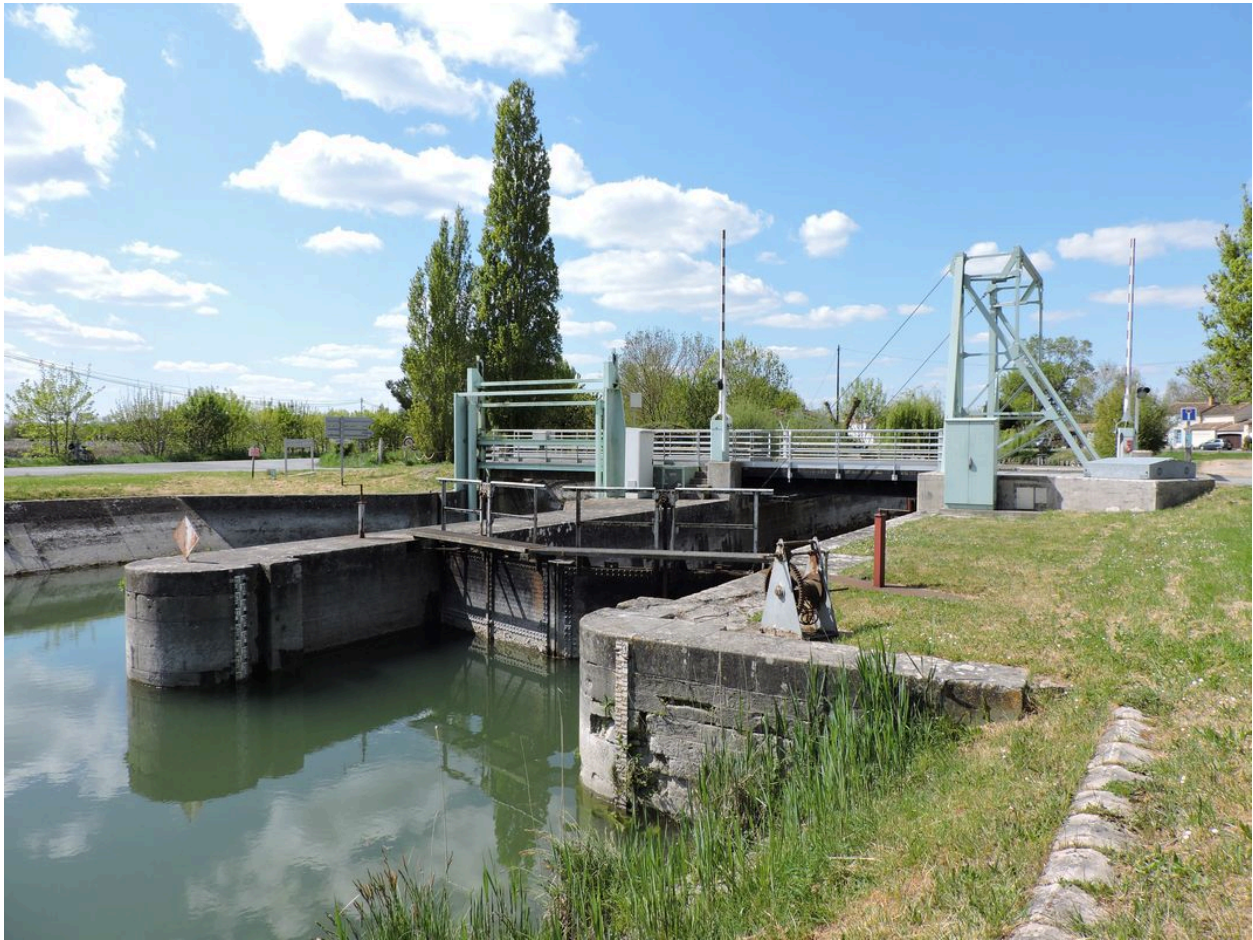
Le barrage éclusé vu depuis l'amont, rive droite.
