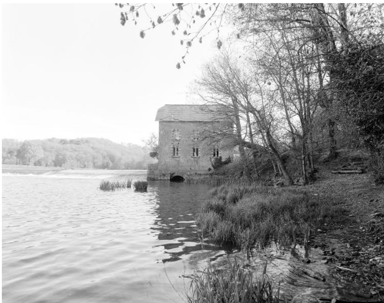
La façade sud-ouest (aval).
