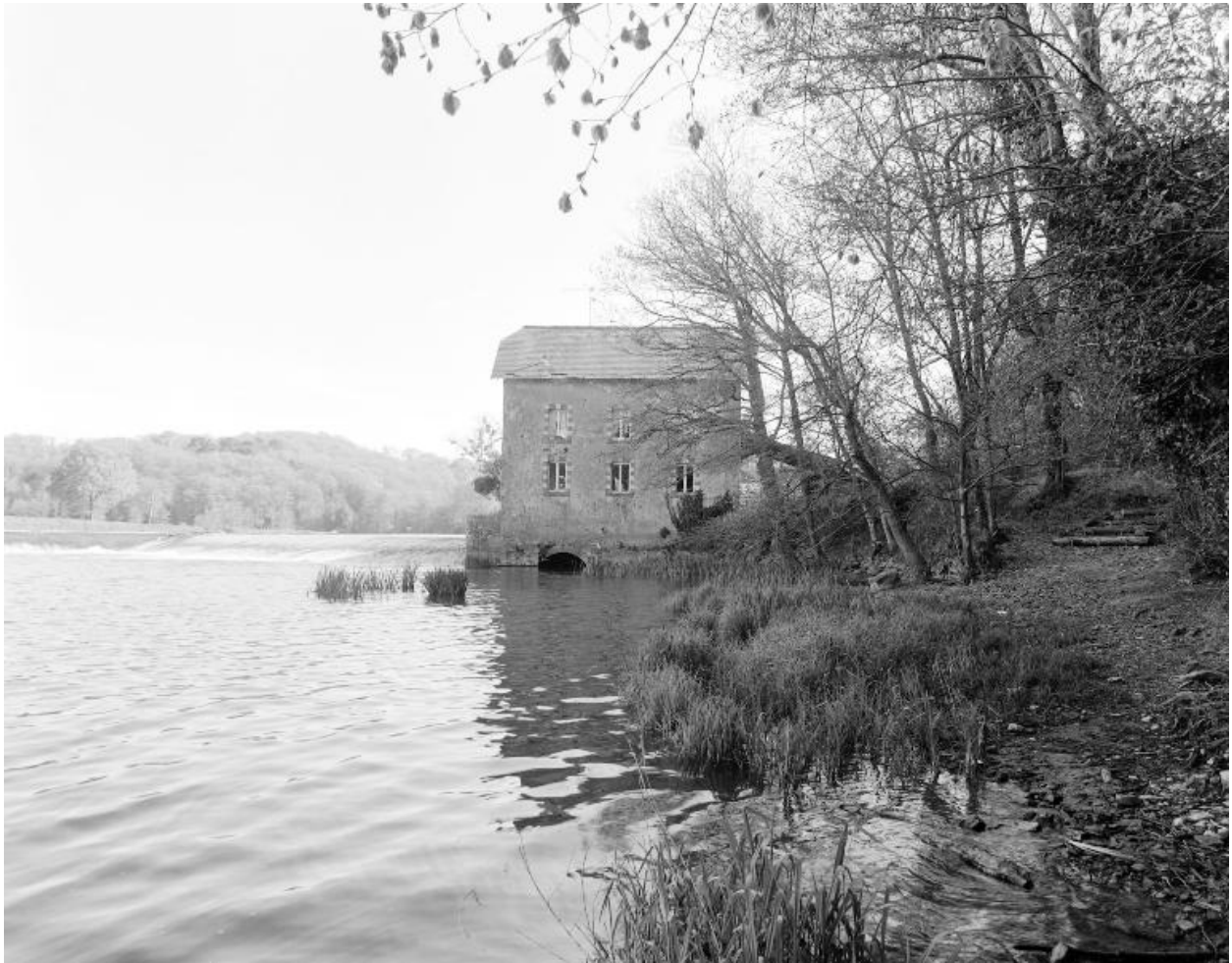
La façade sud-ouest (aval).
