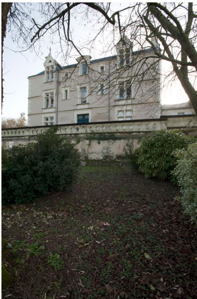
Façade nord et terrasse, face à la Loire.
