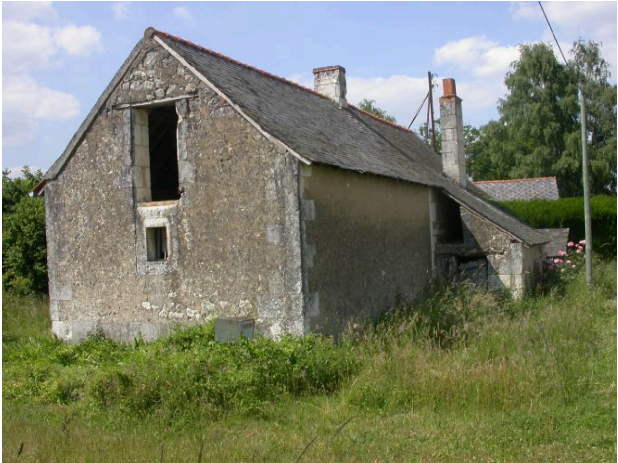
Maison 4, façade postérieure : cheminée avec four (rapportés ?) sur mur goutterot.
