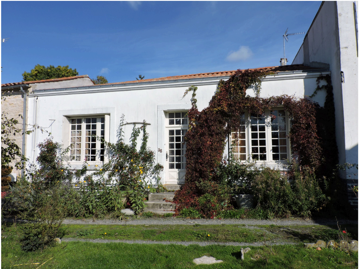
L'aile sud-ouest, vue depuis le sud.
