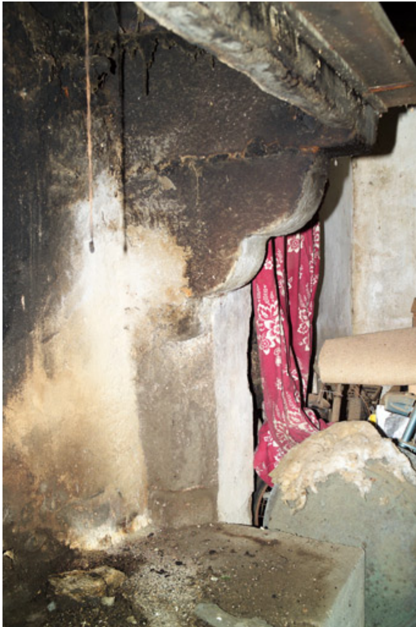
Console droite de la cheminée de l'avant-dernier logement à l'est.
