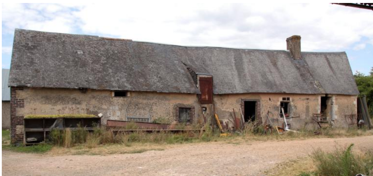
Ferme bloc à terre, Les Roiseries.
