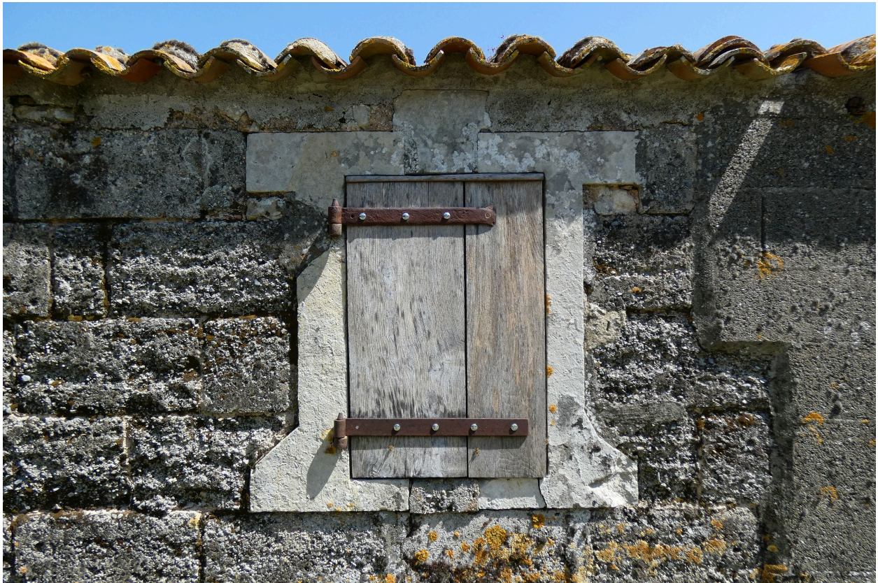
La baie sur le mur gouttereau sud.
