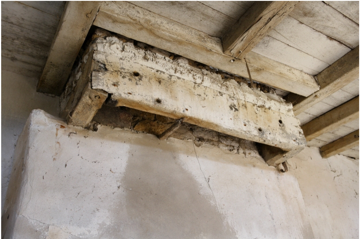
Détail de la cheminée du 1er logis.
