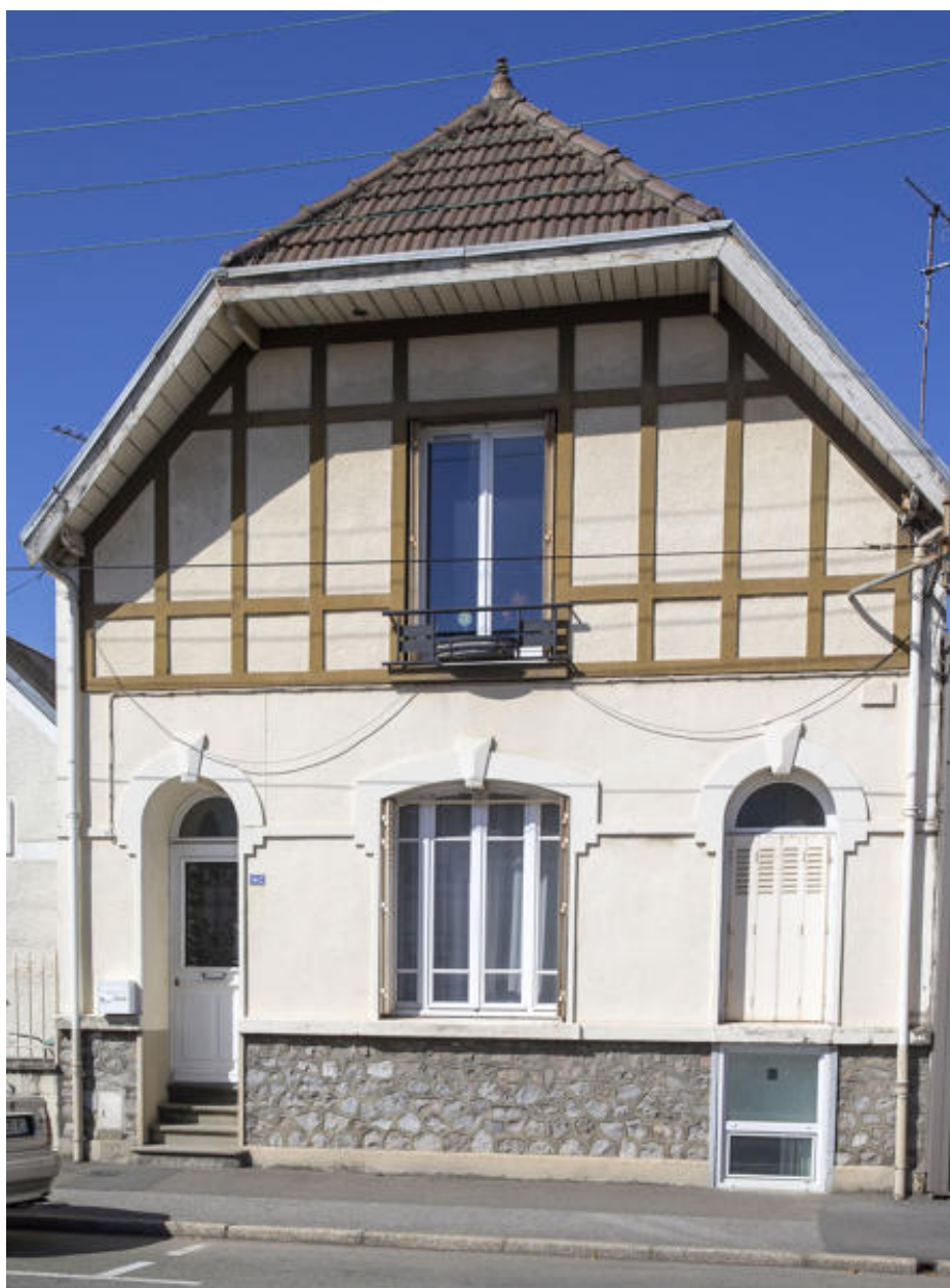
Vue d'une maison avec faux pans de bois avenue Olivier-Heuzé.
