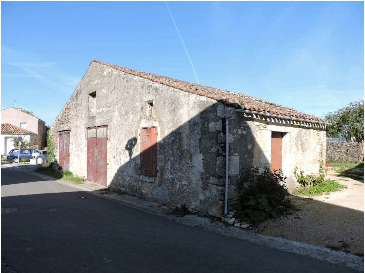
L'ancienne maison vue depuis le sud-est.
