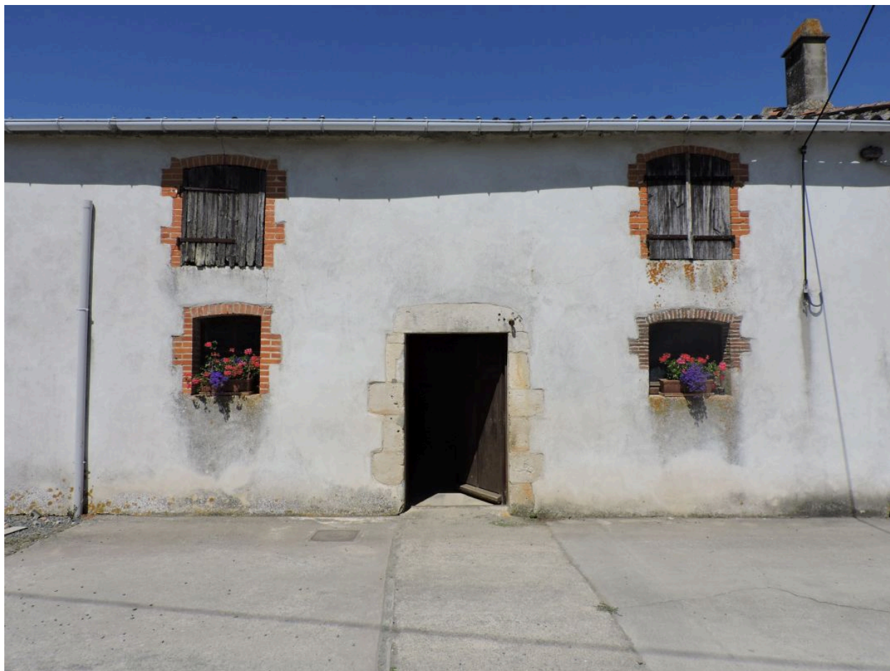
L'ancienne grange-étable et ses ouvertures, vue depuis le sud-est.
