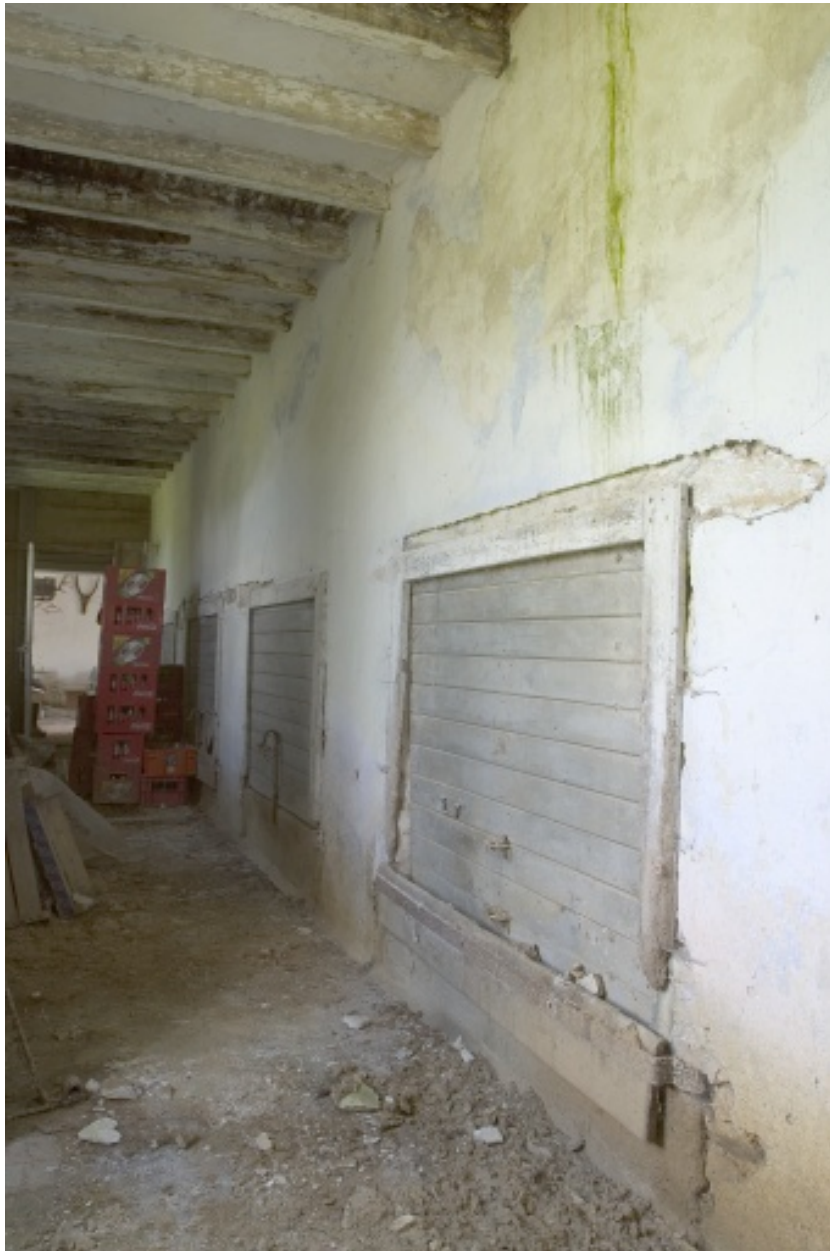
Intérieur de la porcherie : le couloir et les ouvertures servant à l'alimentation des animaux.
