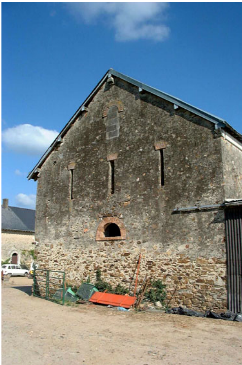
Pignon occidental de l'étable avec demi-lune, fenêtre en plein-cintre et fentes d'éclairage.
