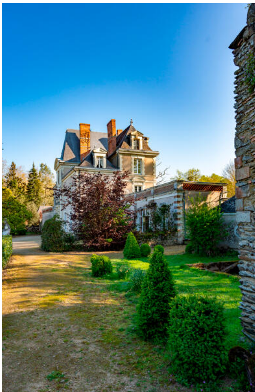
L'élévation latérale, côté sud.
