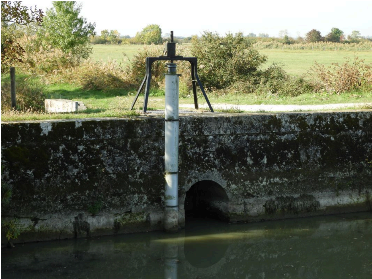
La bonde côté amont, du côté de la ceinture des Hollandais, vue depuis le nord.
