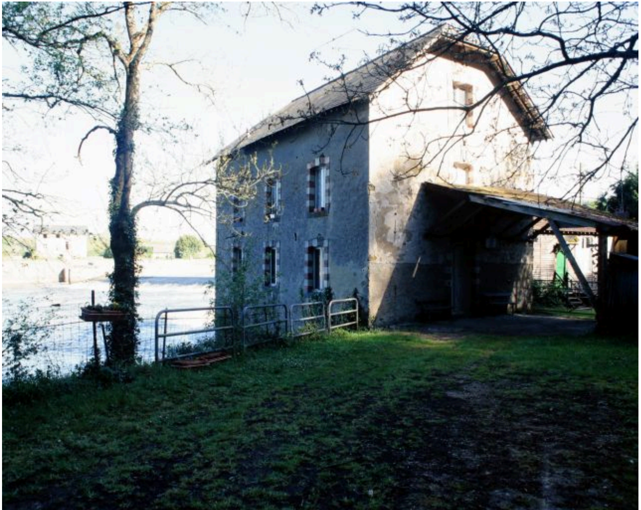
Les façades sud-ouest et sud-est. Au second plan, le barrage et la maison éclusière.
