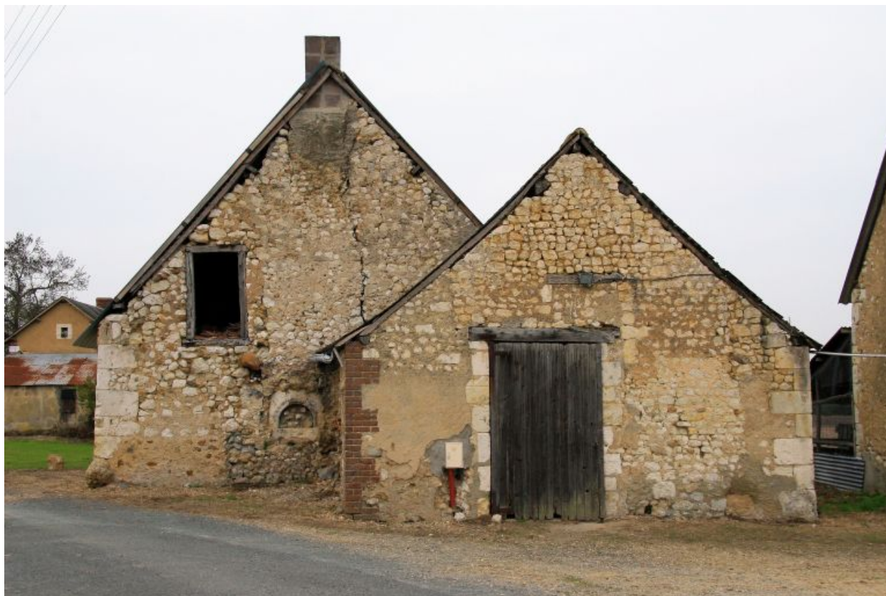
Maison 1, pignon est : vestige du four à pain démoli et nouvelle dépendance.
