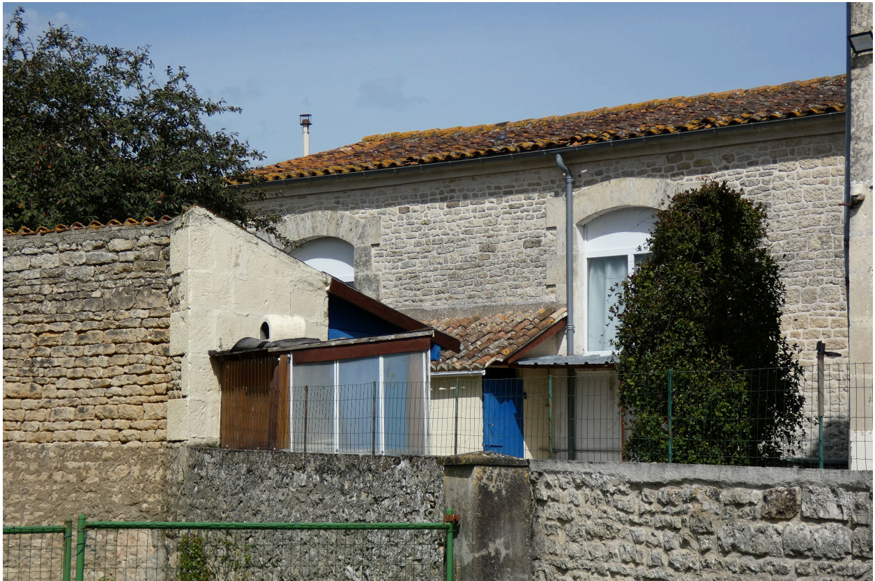
Le bâtiment de classe vu depuis le sud.
