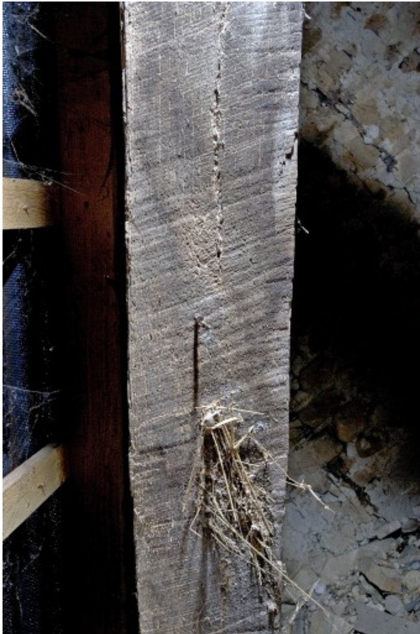
L'ancien logis-étable, charpente, détail de l'un des arbalétriers de la ferme I : traces de sciage.
