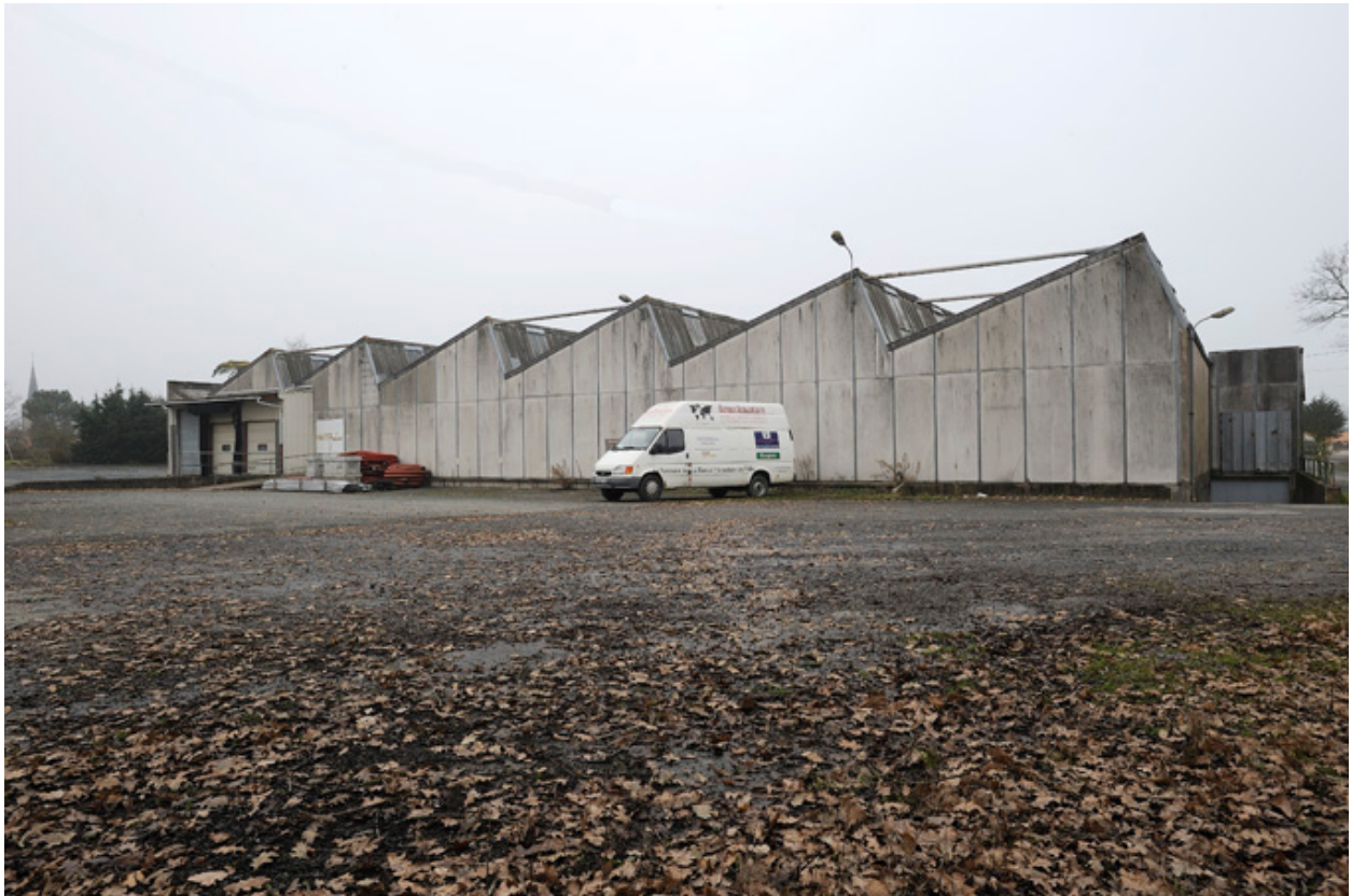
Façade arrière de l'usine La Choletaise (U2).
