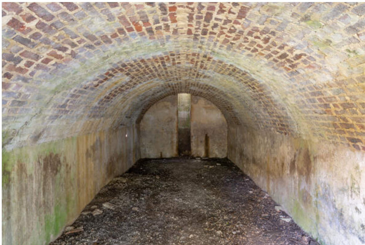
Cellier semi-enterré : intérieur.
